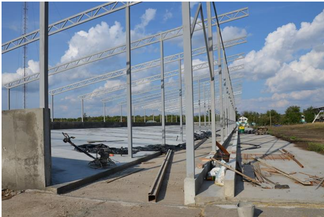
Рис. 1.2.5. Фрагмент будівництва напіввідкритого приміщення для утримання телиць на накопичувальній підстилці з схилом зони відпочинку до алеї перед кормовим столом (ТОВ «Кишенці» Маньківського р-ну Черкаської обл.; власник Корнеліс Хузінха).
