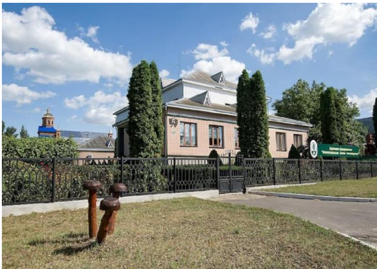
Рис. 3.1. Контора Звенигородського надлісництва [17]
