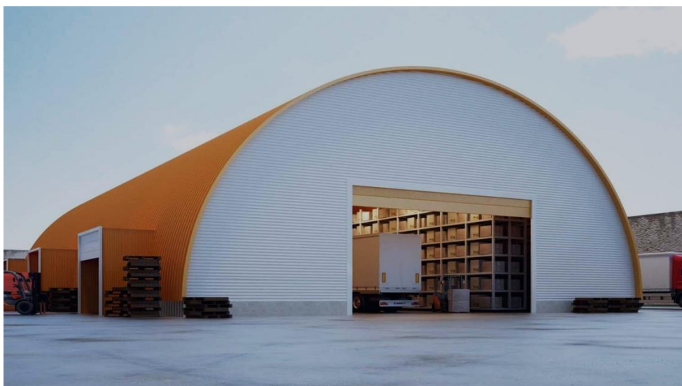
Рис. 1.1. Вигляд безкаркасного сховища арочного типу
