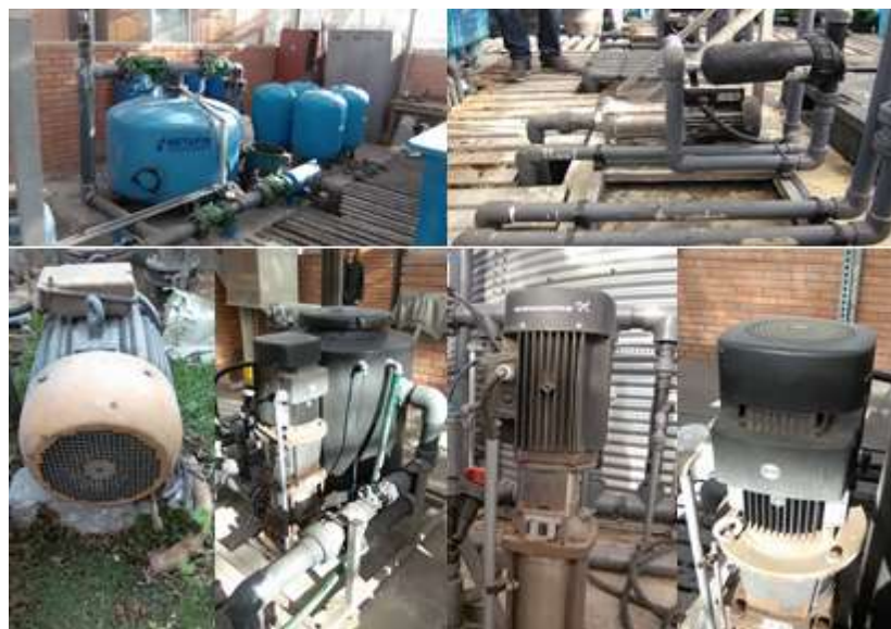
Рис. 2.5. Елементи системи підготовки живильного розчину
