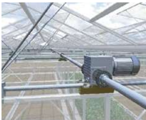
Рис. 2.6. Мотор-редуктор Ridder RW240 для відкриття фрамуг
