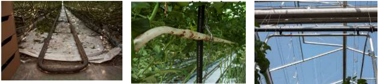
Рис. 2.4. Трубна система опалення теплиці:
