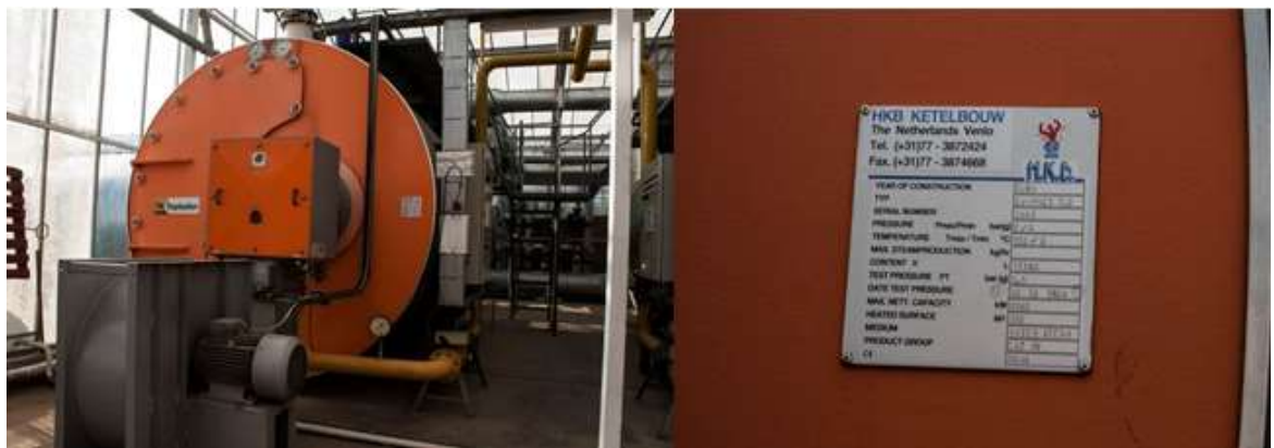
Рис. 2.1. Зовнішній вигляд водогрійного котла Witomax-200 тепличних комплексів
