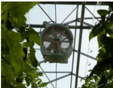
Рис. 2.7. Рециркуляційний вентилятор промислової теплиці
