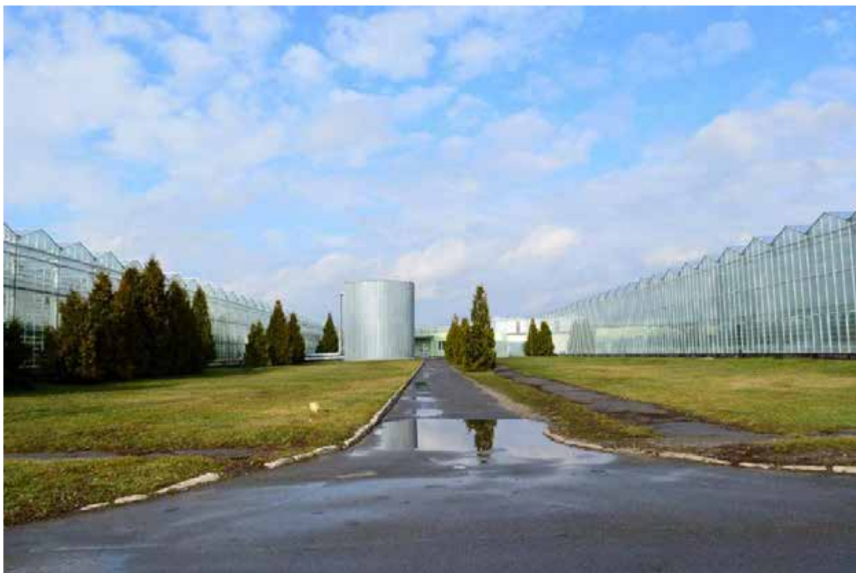
Рис. 2.1. Теплиці ПрАТ “Комбінат” Тепличний”
