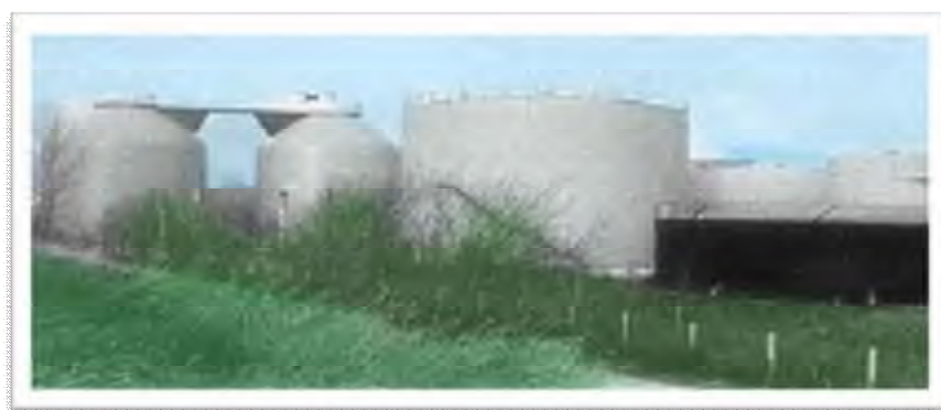
Малюнок 1.2 Комунальна біогазова установка (анаеробний етап очисної споруди)
