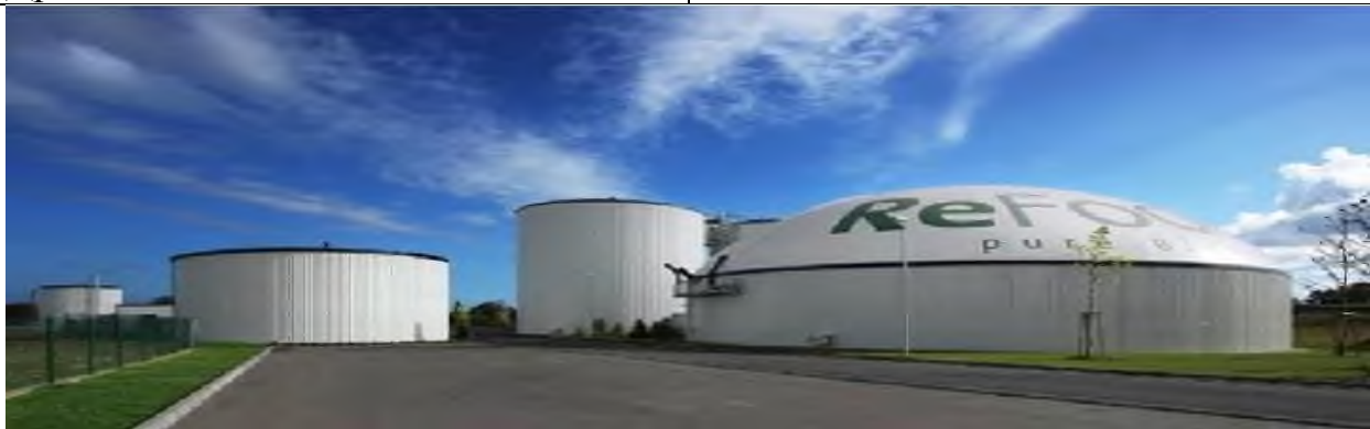
Малюнок 2.11 Біогазова установка німецького виробництва, потужністю 15 кВт.[16]
