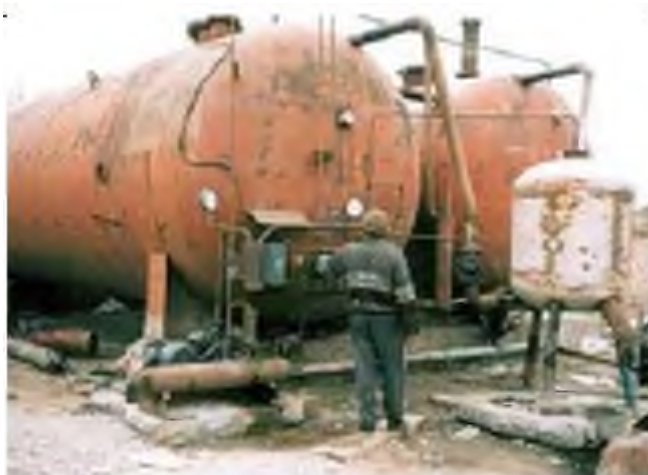
Снімок во время монтажа, сейчас установка находится в закрытом помещении
