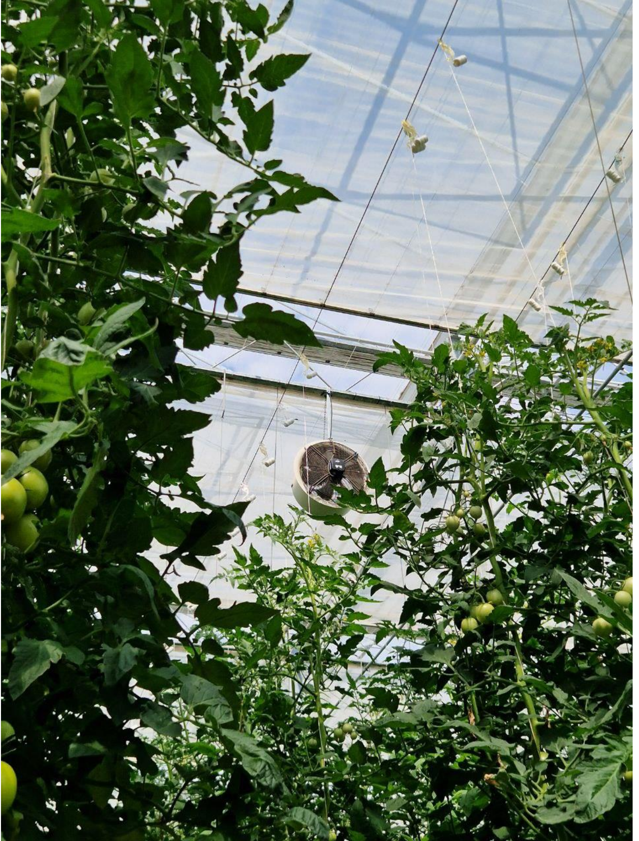
Рис. 1.2 Приклад циркуляційного вентилятора на промисловій теплиці
