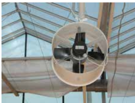
Рис. 1.10. Рециркуляційний осьовий вентилятор теплиці Система електродосвічування рослин (в розсадному відділенні).
