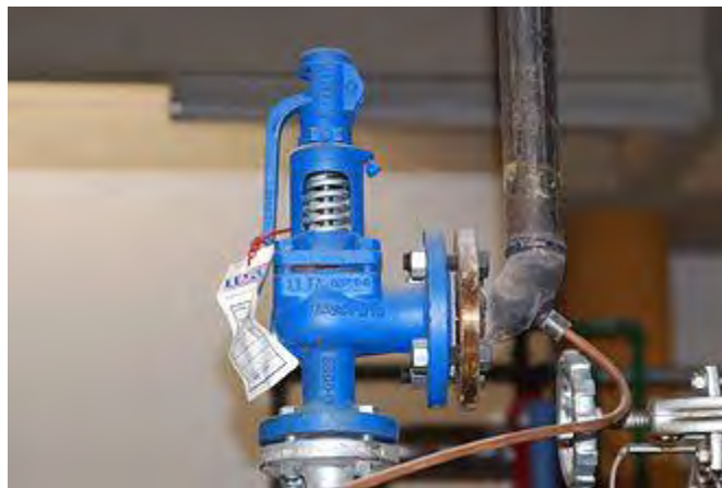
Рис. 3.10. Пружинний запобіжний клапан
