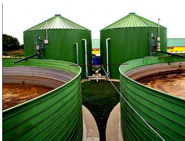
Рис. 6.19 Споруди для відстоювання рідкого гною типу лагуна (а) та гноєнакопичувачі (б).
