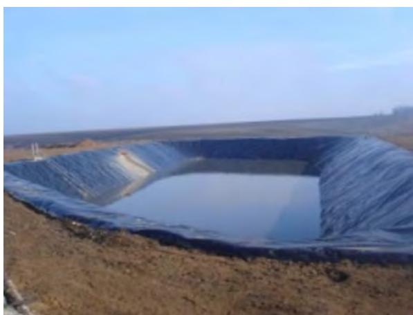
Рис. 6.19 Споруди для відстоювання рідкого гною типу лагуна (а) та гноєнакопичувачі (б).
