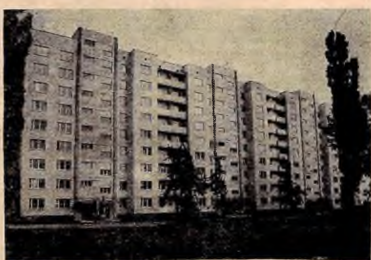
Новий житловий будинок по вулиці Андрія Бубнова, в якому мешкатимуть співробітники нашої академії.
