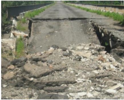
Рис. 2. Пошкоджені автомобільні дороги з асфальтовим асфальто-бетонним покриттями.
