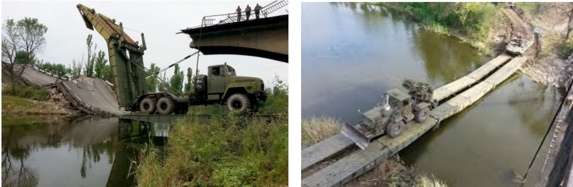
Рис. 5. Момент наведення тимчасових автомобільних мостів (переправ) із металевих конструкцій.
