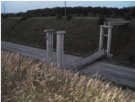
Рис. 3. Пошкоджені автомобільні мости.
