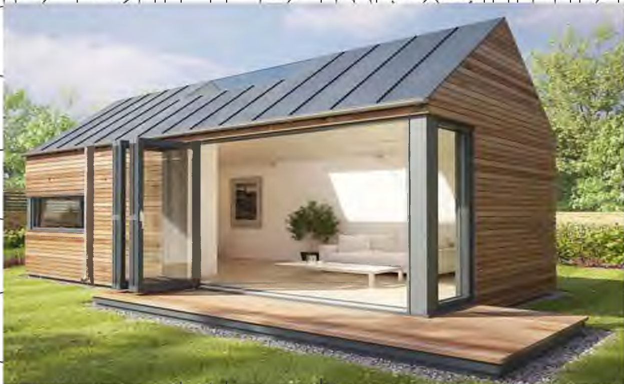
Рис. 2.1. Модульний будинок обшитий дерев'яною фасадною дошкою [16]
