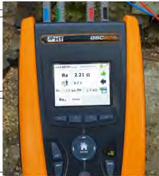
Рисунок 6.4 Покази приладу при проведенні обстеження контуру заземлення
