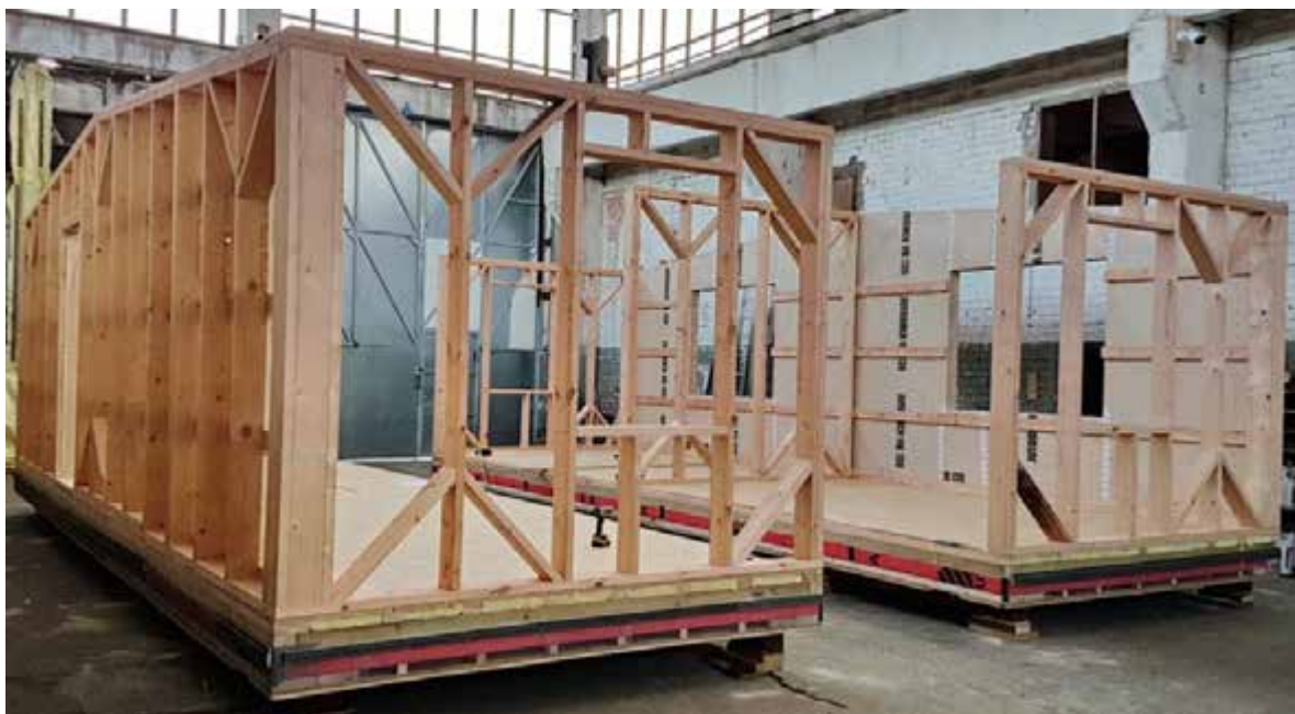
Рис. 1. Дерев'яний каркас модульного будинку
