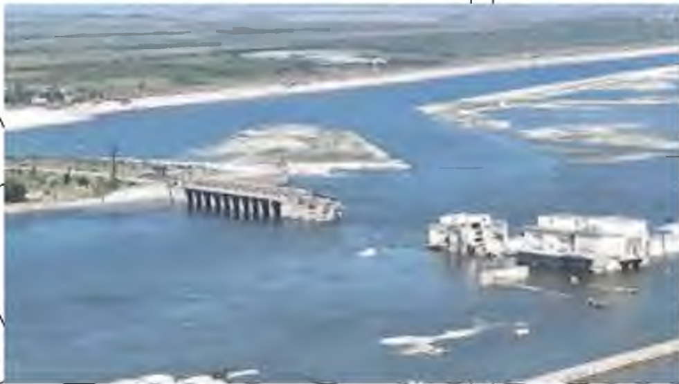
Рис.3.2. Зруйнована дамба Каховської ГЕС
