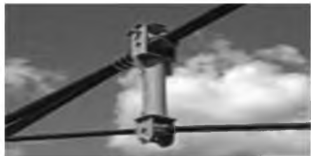
Рис. 2. Двопоясна конструкція висячого покриття
