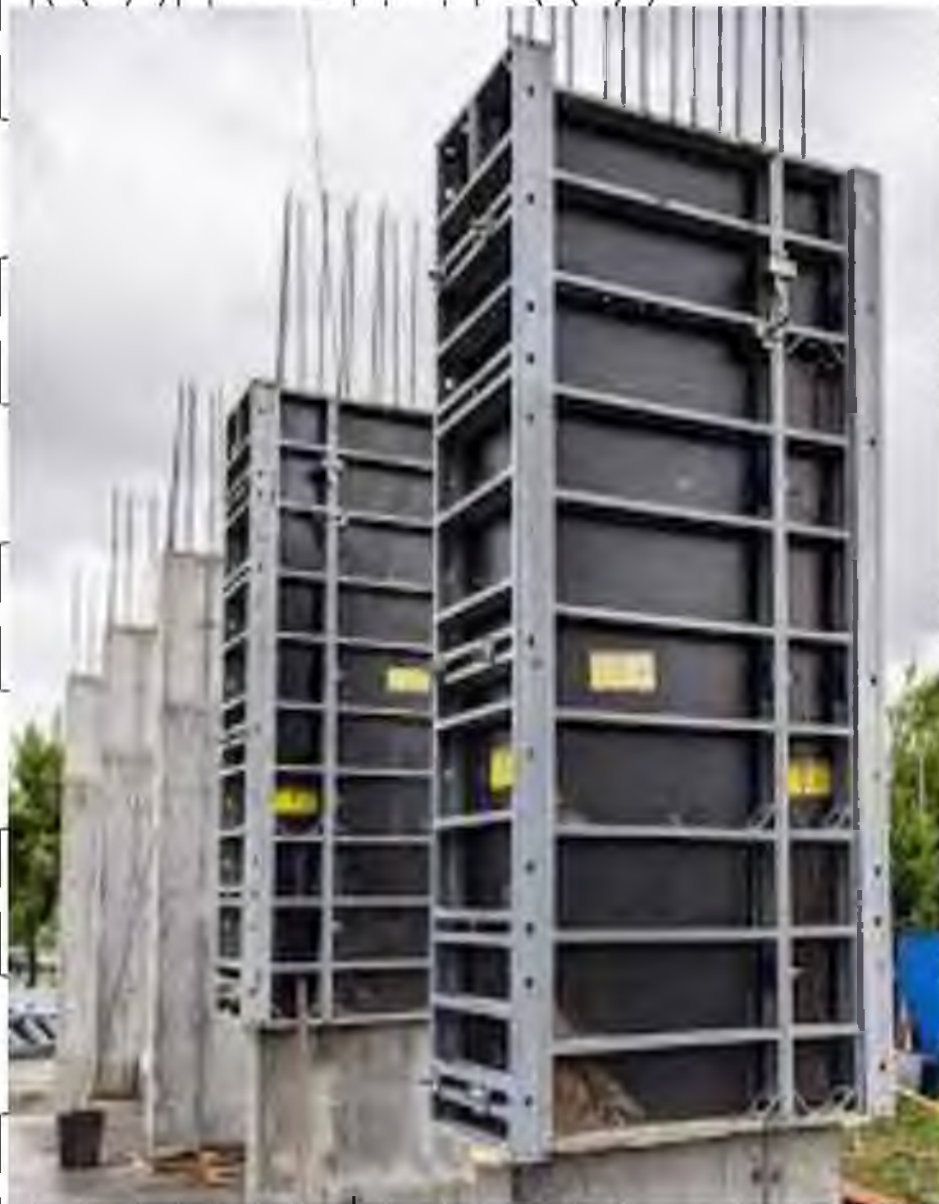
Рис. 2. Опалубка для заливки вертикальних елементів [6]
