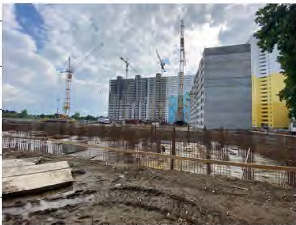
Рис. 2 Фотографія котловану на досліджуваному об'єкті [27]
