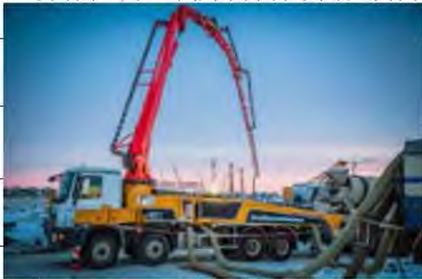
Рис. 3.3. Установка з автоматичної подачі бетонної суміші
