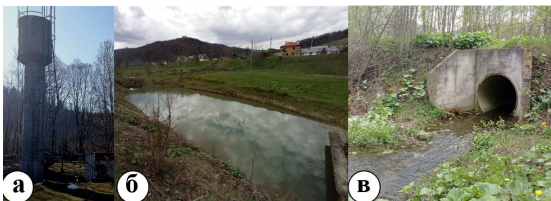
Рис. 3.5. Складові водопостачальної та водоскидної мережі: а – водозабірна вежа, б – відстійний став, в – водоскид (власні фото)
