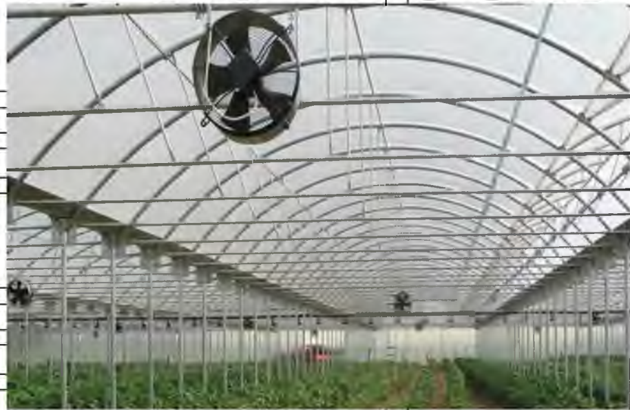
Рис.1.5 Система вентиляції в теплиці
