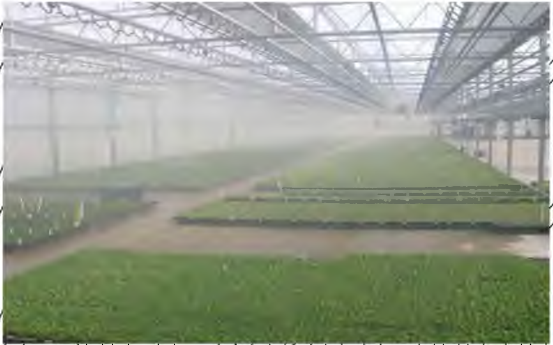
Рис. 1.7 Система пошиву туману в теплиці
