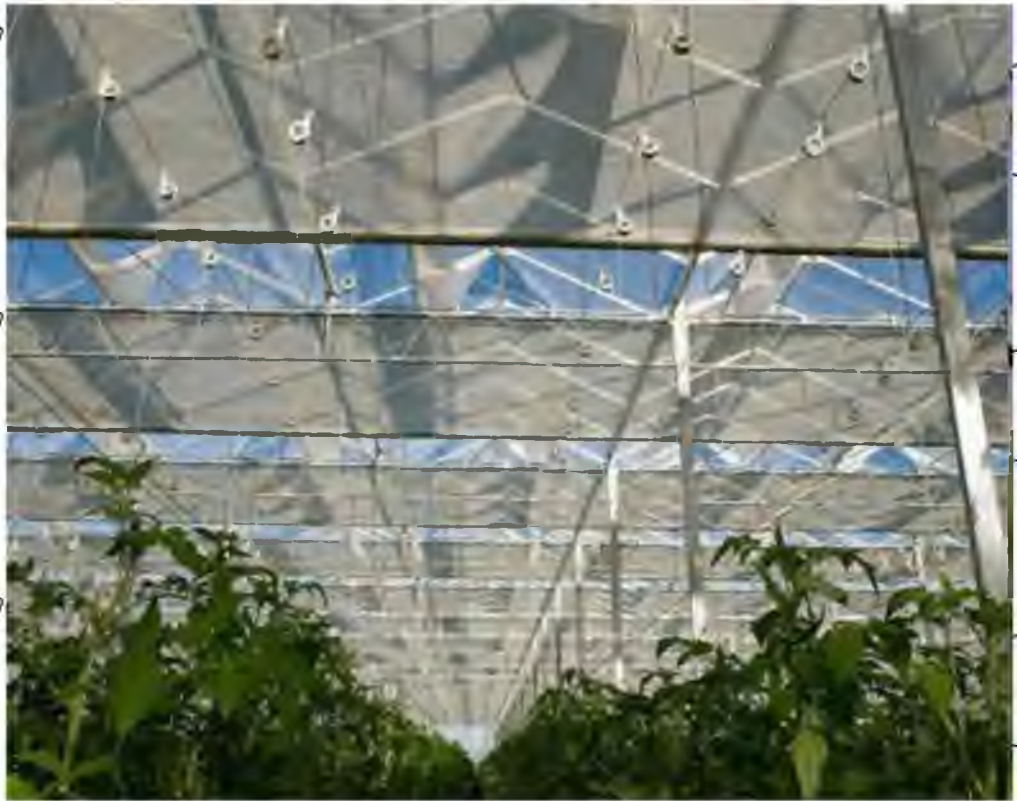
Рис.1.6 Система зашторювання в теплиці
