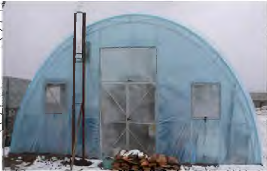
Рис 2.2 Вхідна група теплиці з внутрішнім тамбуром, 2021 р.
