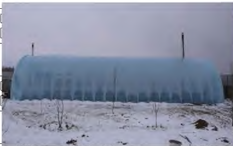
Рис. 2 1 Плівкова 2-шарова теплиця, 2021 р.
