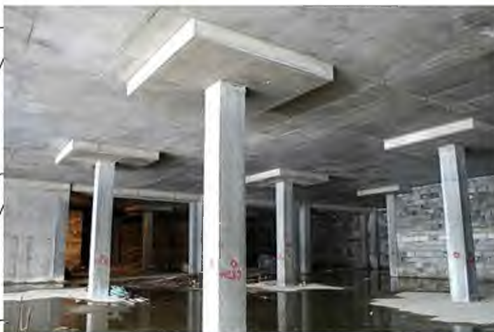
Рис. 7.2 Підплення келосин за допомогою капітелей
