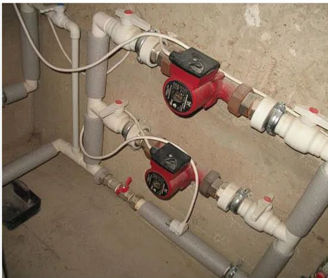
Рис. 2.2. Зображення циркуляційних насосів
