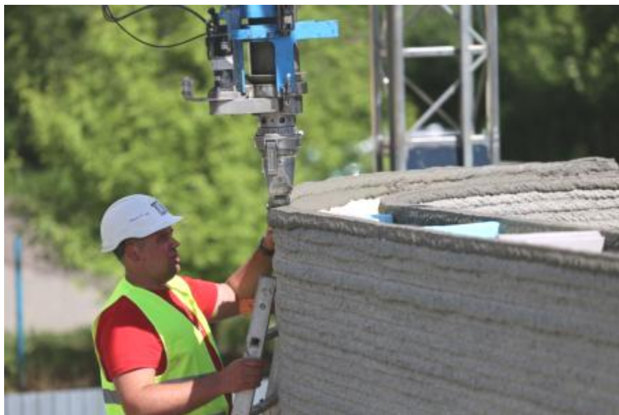
Рис. 1 Будівництво навчального закладу у Львові
