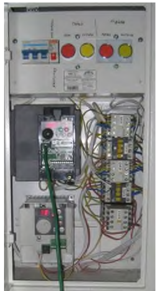
Рис. 3.6. Частотний перетворювач FR-S540-E-2.2K-EC в загальній шафі автоматичного керування моделями
