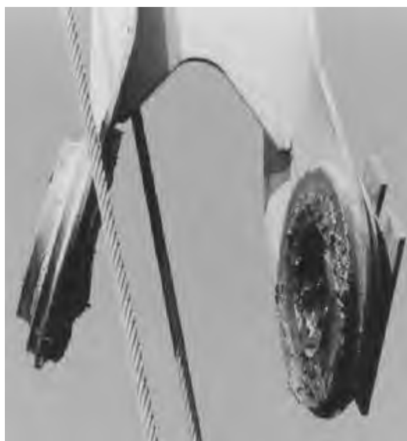
Рис. 1.16. Зруйнований шарнір «тяга коромисла–стріла».
