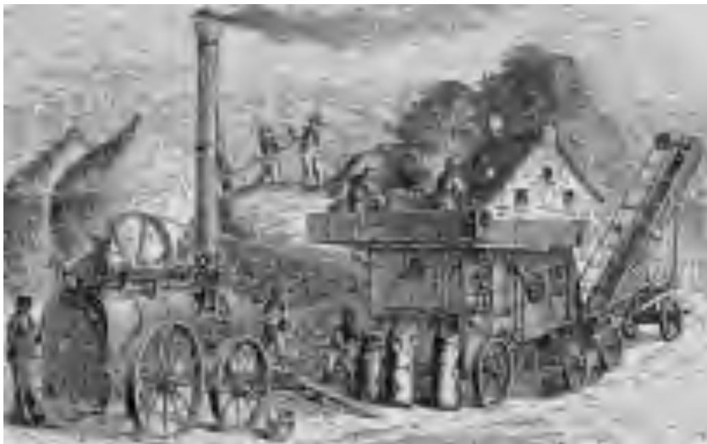
Рис. 8. 29. Складна молотарка з приводом від локомотива
