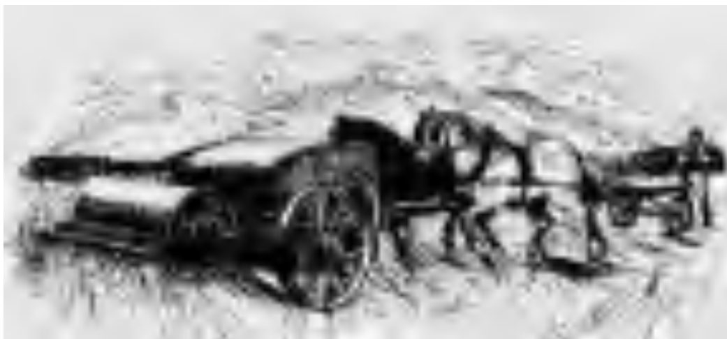
Рис. 8. 34. Колосозбиральна машина (жатка) Джона Рідлі (1843 р.)
