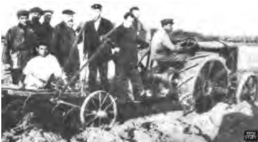
Рис. 4. 39. Трактор Фордзон-путиловець з причіпним пługом під час оранки
