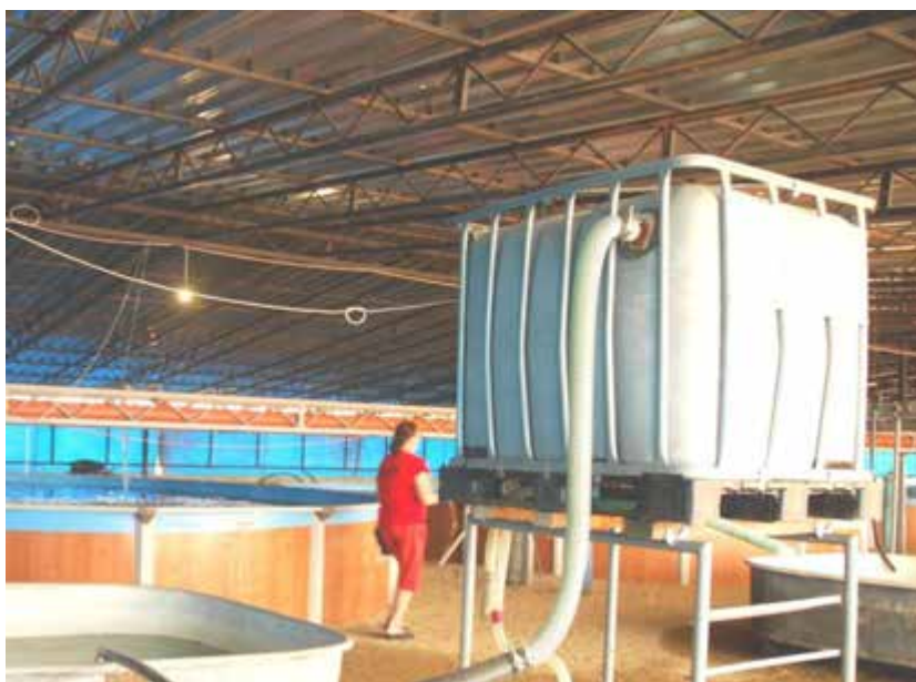
Рисунок 3.1. Бак – дегазатор, наповнений спеціальним завантаженням.
