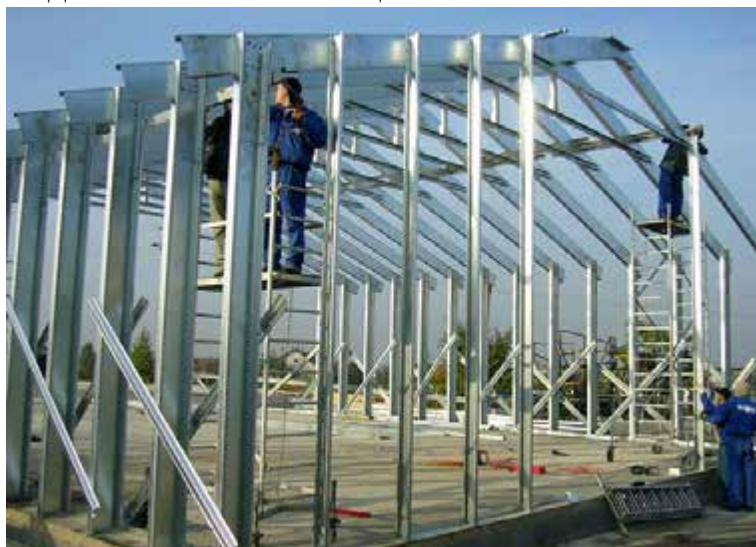
Рис. 1. Металевий каркас одноповерхової будівлі.
