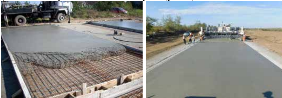
Рис. 2. Застосування полімерцементного бетону
