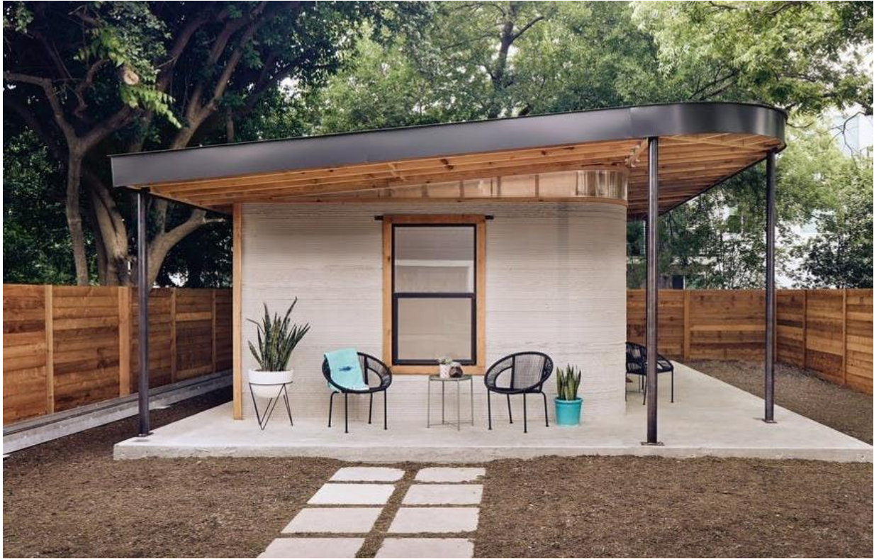
Рис. 1. Будівля виконана 3D друком
