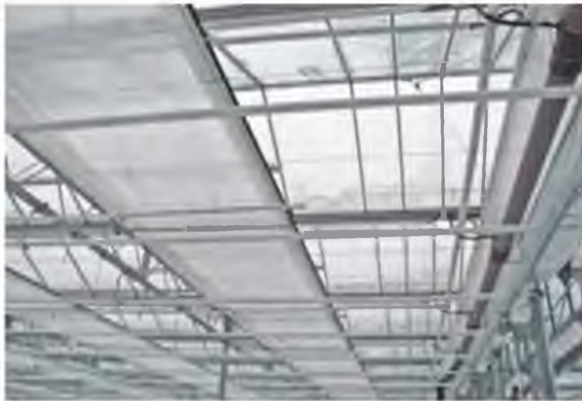
Рис. 1.11. Загальний вигляд системи зашторювання
