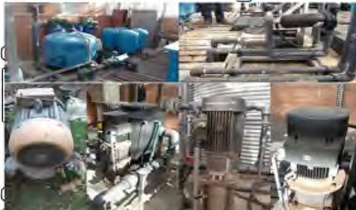
Рис. 1.8. Елементи системи підготовки живильного розчину
