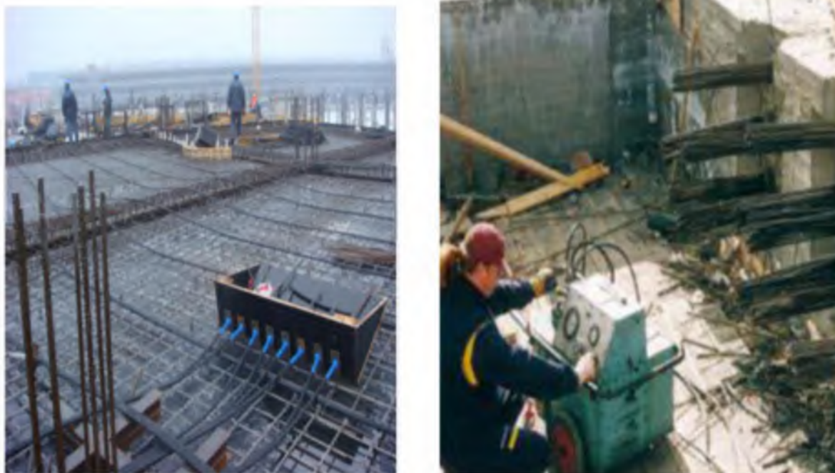
Рис.1. Приклад попереднього напруження армування
