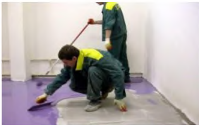
Рис. 2. Нанесення кольорового базового шару
