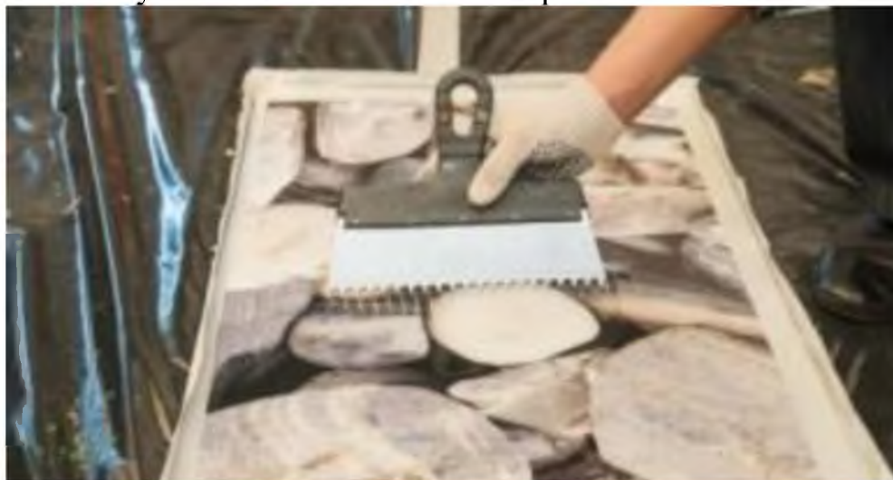
Рис. 3. Розгладження лаку за допомогою зубчастого шпателя
