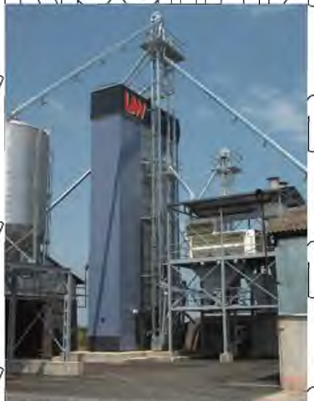
Рис. 1.5. Шахтна зерносушарка LAW типу SBC-LE
