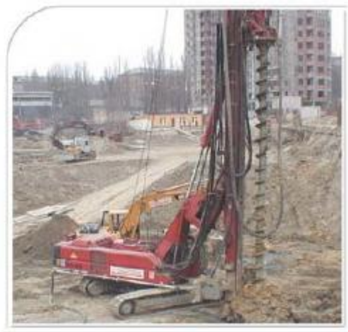
Рис. 3.1 Установа ін'єкційних паль
