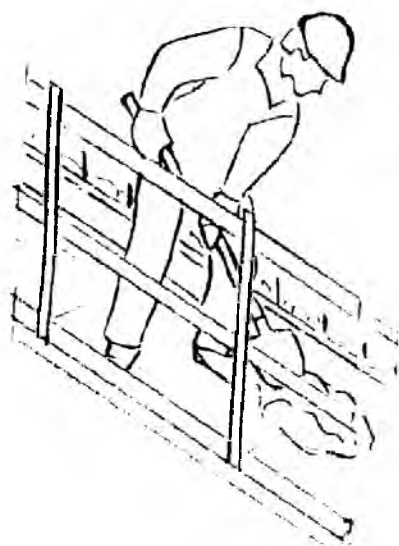
Рис.3.8. Очищення прийкеомає поданий, що пролився, з дерев'яного настилу підмостей лопатами бетону і опалубки
