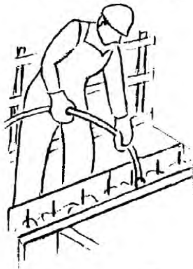
Рис.3.7. Ущільнення уених шарів бетонорамної суміші
