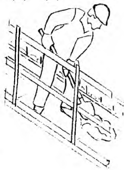
Рис.3.10. Очищення настелу підмостей бетонцу, що пролився,
