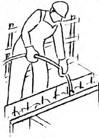
Рис. 3.9. Ущільнення вібраторами шарів бетонної суміші глибинними або укладених поверхневими
