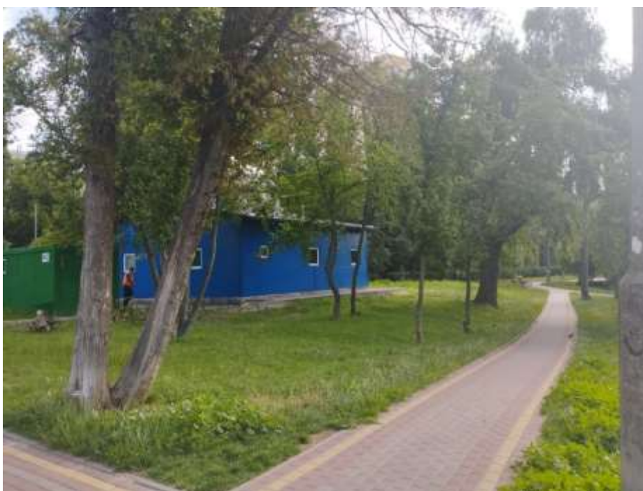
Рис. 3.12. Господарська будівля і туалет (фото автора)
