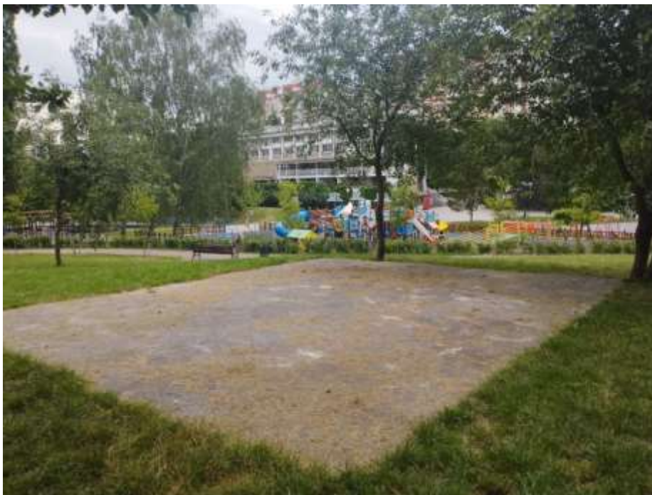
Рис. 3.20. Бетонний майданчик (фото автора)
