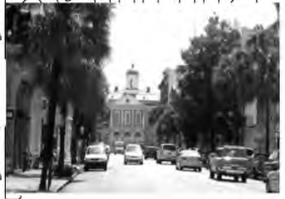
Рис. 1.8. Відреставрована будівля старої біржі, що розташована вкінці Брод-стріт - один з найважливіших громадських об'єктів центральної частини Чарльзтона. [19]
