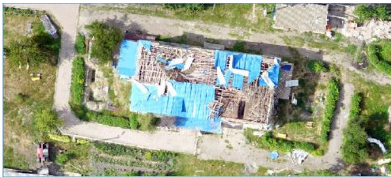
Рисунок 1. Фото зруйнованого об'єкту моніторингу
