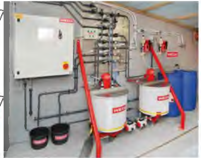
Рис. 2.5. Елементи системи рідкої годівлі свиней Weda
