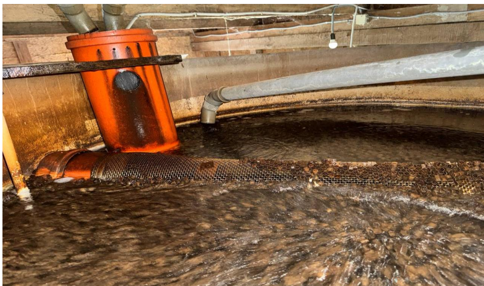
Рис 2.8. Біологічний фільтр
