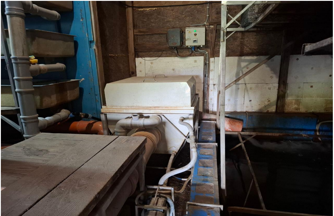
Рис 2.9. Механічний фільтр
