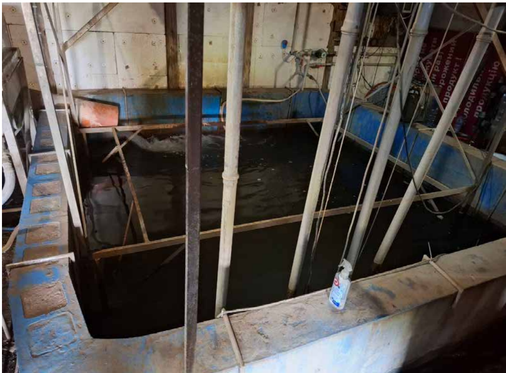
Рис 2.10. Відстійник
