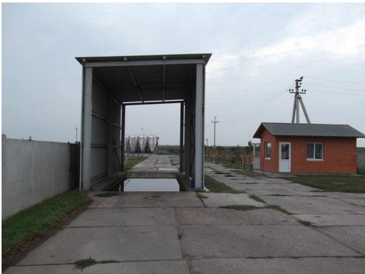
Рис.4 Дезінфікуючий бар'єр для обробки коліс автотранспорту
