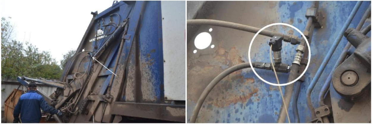
Рисунок 3.3 – Місце встановлення датчиків тиску
