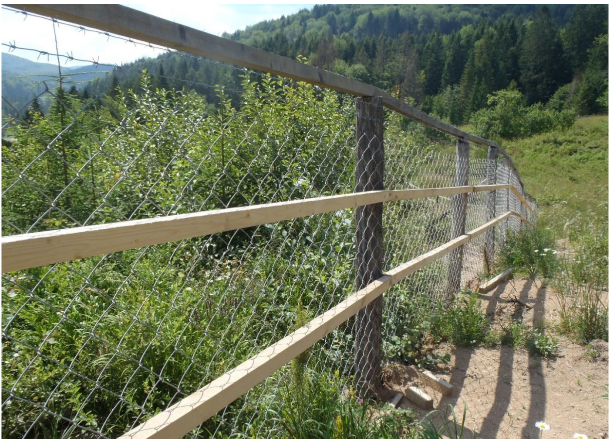
Рис. 3.4 – Поєднання в огорожі дерев'яних та дротяних елементів
