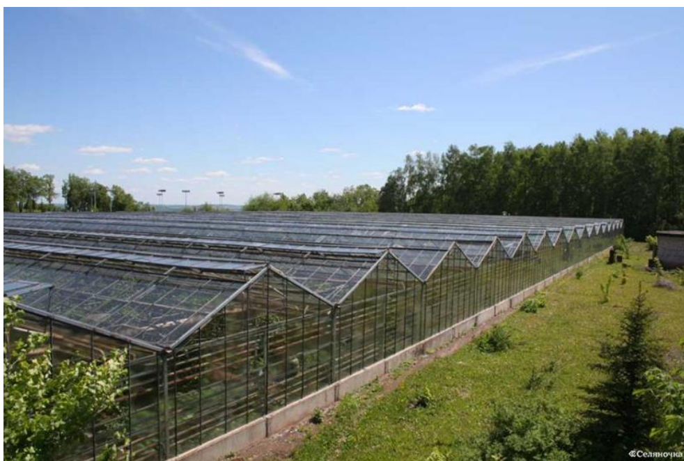
Рис. 1.1 Загальний вигляд блочної теплиці
