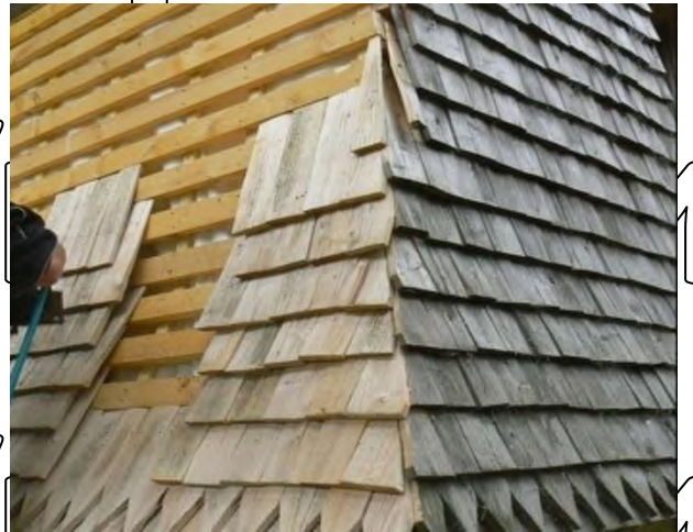
Рис. 4.3. Використання сухостійної деревини сосни: а – будівельні конструкції; б – гонт (покрівельний матеріал) [48]
