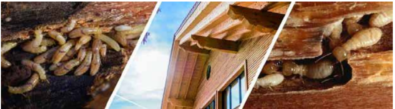
Рис. 1.1. Пошкодження комахами дерев'яних елементів [5]
