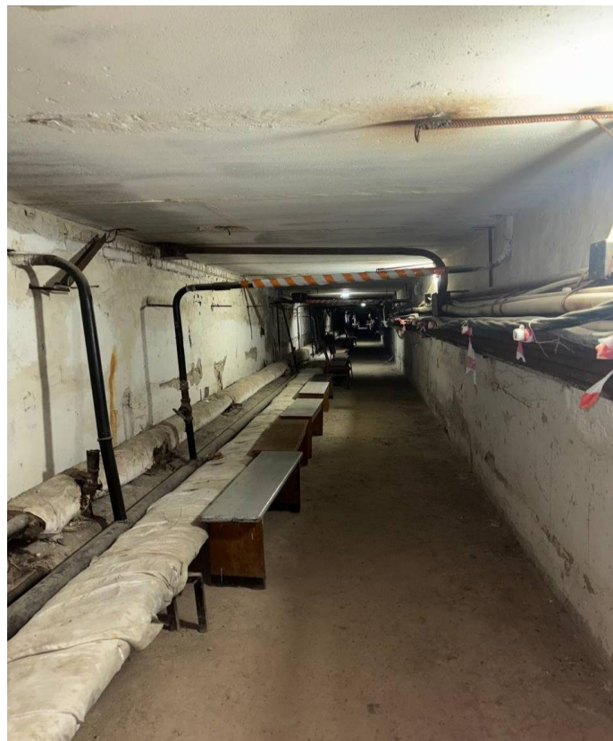
Рис. 4.1. Основний коридор підвального приміщення
