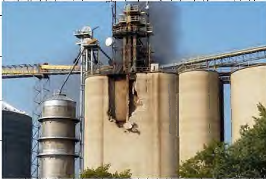
Рис. 1.6. Наслідки вибуху зернового пилу в елеваторі у США (штат Айова), що стався у 2020 р.
