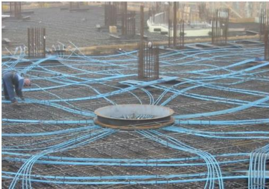
Рис. 2. Постнапруження сталевих ниток у трубах
