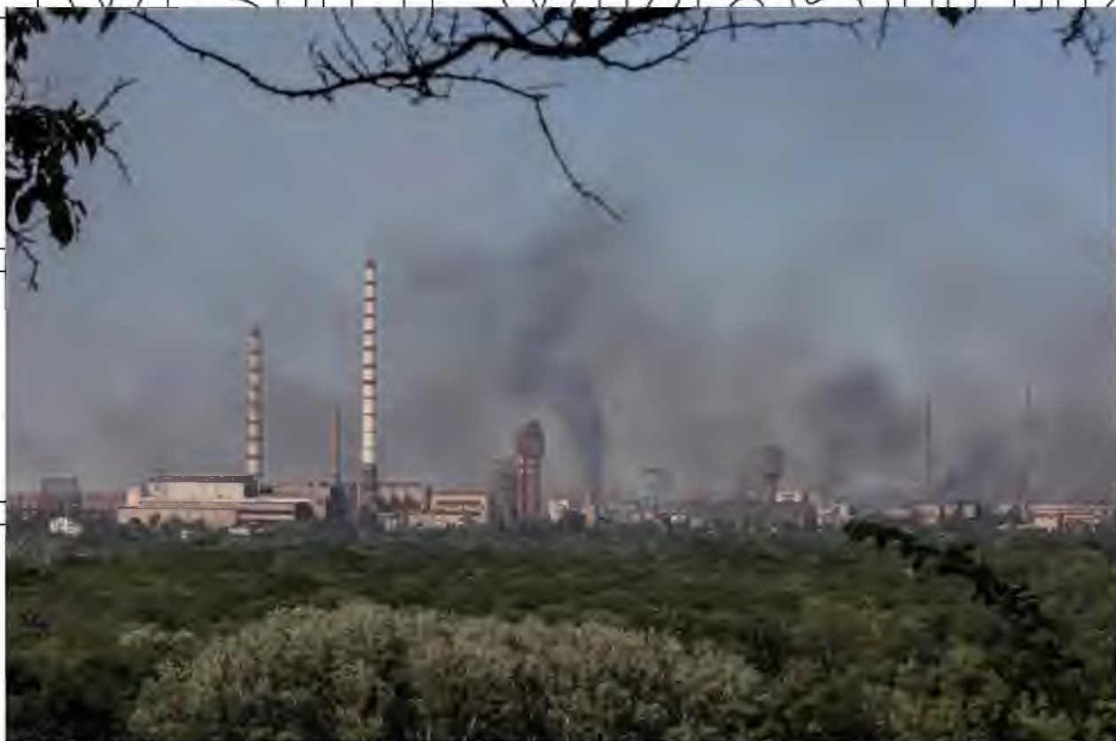
Рис. 2.2. ПрАТ «Северодонецьке об'єднання Азот» 10.06.2022р.
